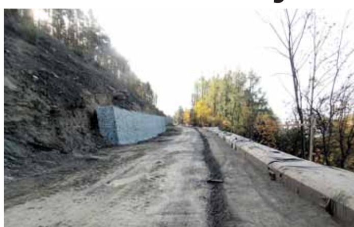
■ Rozšířený a narovnaný průtah Brtnic na silnici II/405 bude otevřen do konce roku.
