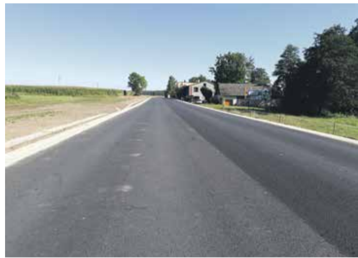
■ Modernizací letos prochází další úsek krajské páteřní silnice II/602 z Jihlavy na Pelhřimov. Část u Hubenova má být otevřená se závěrem října.
