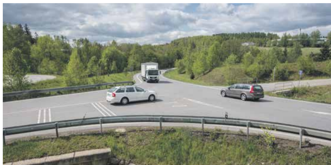
■ V místě současného křížení silnic II/523 a I/38 v jihlavské lokalitě nazývané V Ráji vznikne jedna z velkých okružních křižovatek.
