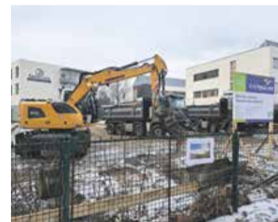
V půlce ledna se bagry naplno zakusily do terénu na Batelovské ulici, kde do roka vyrostou nové výjezdové místo telčských záchranářů.
