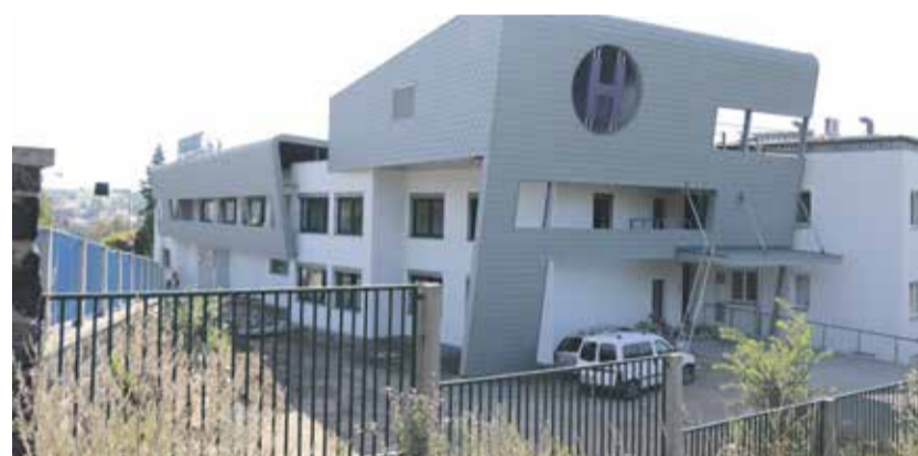
Novoměstská nemocnice dokončila modernizaci vstupního pavilonu. FOTO: HELENA ZELENÁ KRÍŽOVÁ
