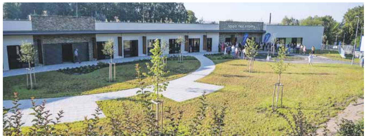
Hospic je uspořádán do půlkruhu. Z každého pokoje je výjezd na terasu, což umožní klienty vyvézt ven na čerstvý vzduch. FOTO: LIBOR BLÁŽEK
