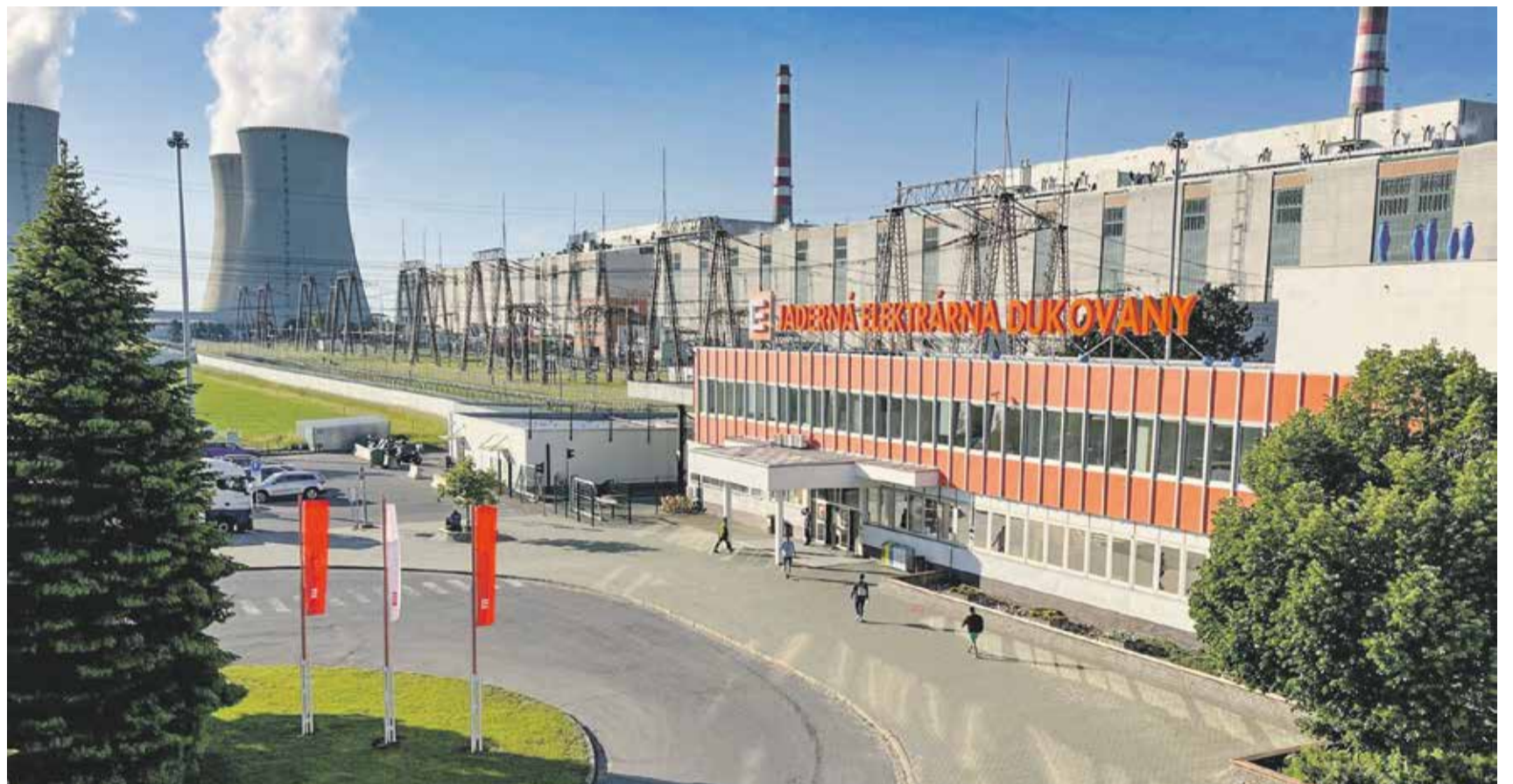
Stavební práce na nových blocích začnou v polovině roku 2029. FOTO: EVA FRUHWIRTOVÁ
