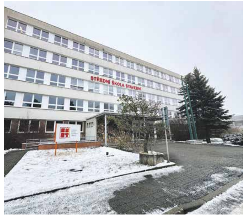
Třebíčská střední stavební škola čeká na novou fasádu. Zřizovatel, Kraj Vysočina, vypsal výběrové řízení na dodavatele. FOTO: EVA FRUHWIRTOVÁ
